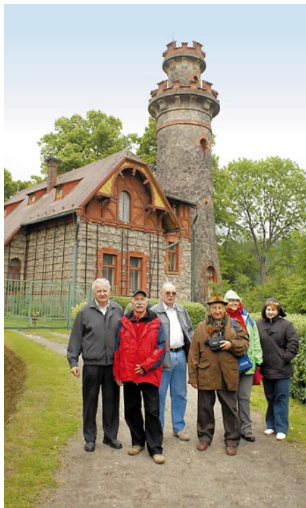
Budynek obsługi zapory i elektrowni
