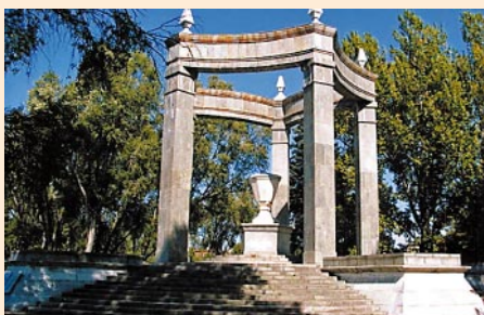
Fot. 2. Widok panteonu – zbliżenie
