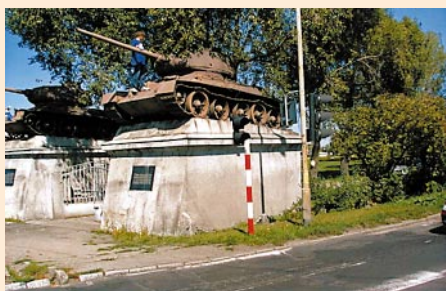
Fot. 6. Widok cokołu pod czołg
