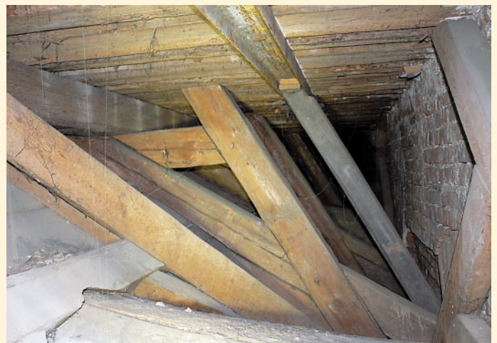
Wygląd wykonstruowania „pachy sklepienia drewnianego”
