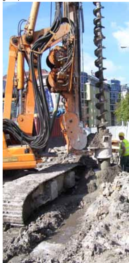
Wykonywanie przepony poziomej ścian budynku (widoczne otwory iniekcyjne wraz z umieszczonymi w nich pakierami, fot. Piotr Organek) Wykonywanie palisady metodą CFA (fot. Piotr Organek)
