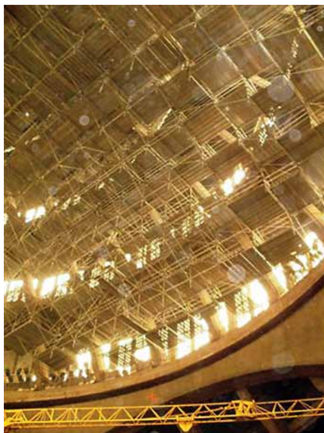
Rusztowanie podwieszone do kopuły
