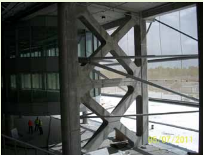
Fot. 4. Nowy element stężący wykonany na mokro
