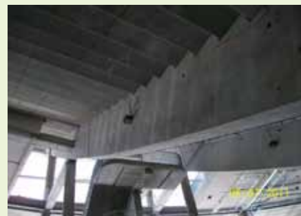
Fot. 3. Prefabrykowana belka trybun
