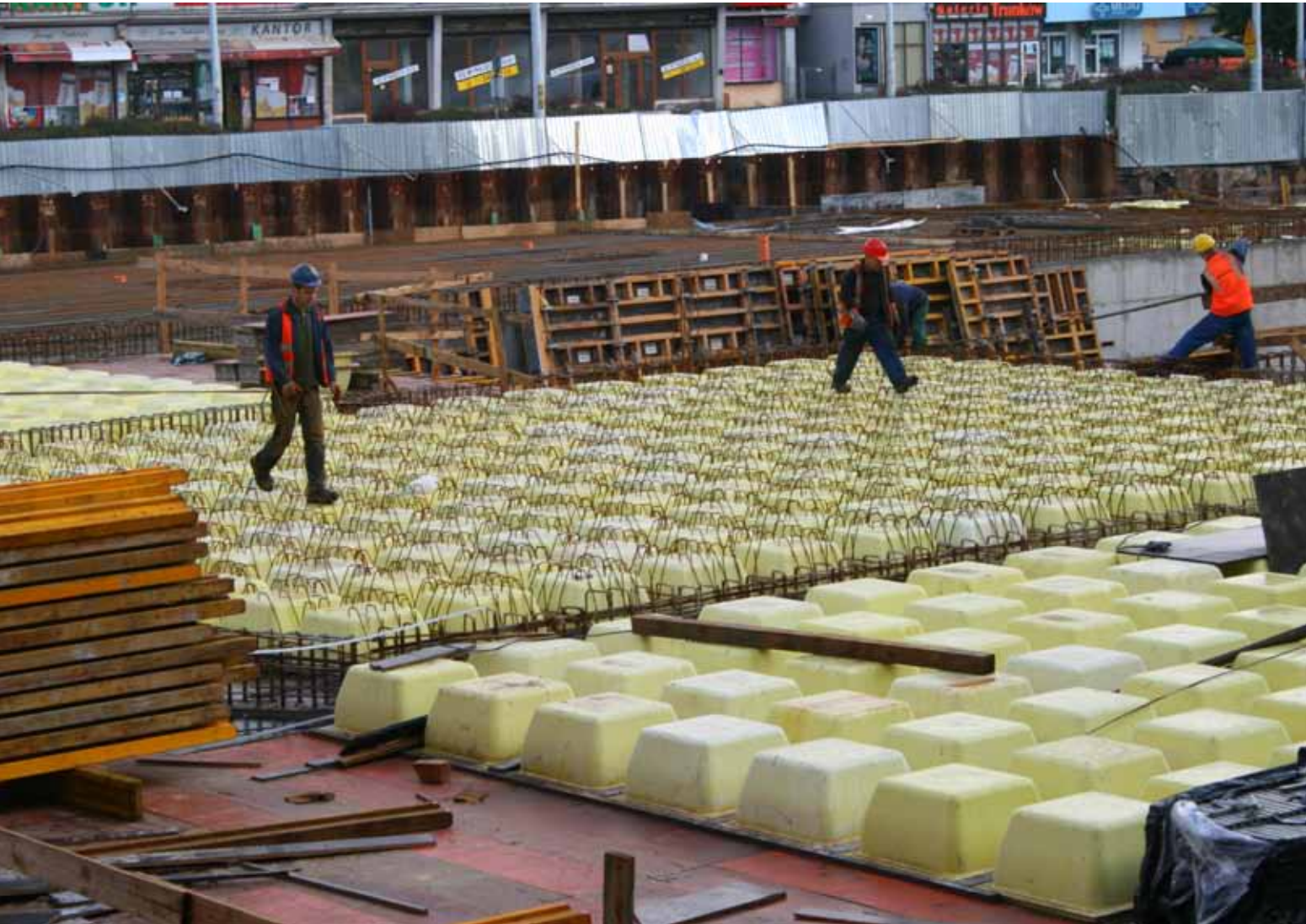
Wykonywanie stropu kasetonowego nad parkingiem (fot. Marek Łużyński)
