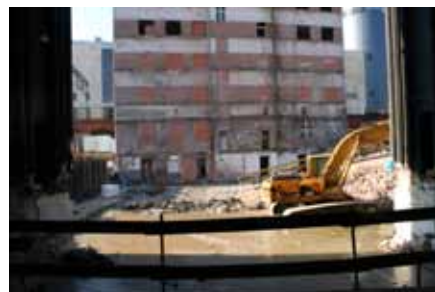
Widok na scenę Teatru oraz wykop, w którym powstanie nowy budynek łączący dawny budynek hotelu Odra z pozostawioną częścią Teatru (fot. Marek Łużyński)
