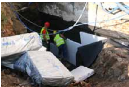
Wykonywanie izolacji pionowej ścian budynku (fot. Marek Łużyński)
