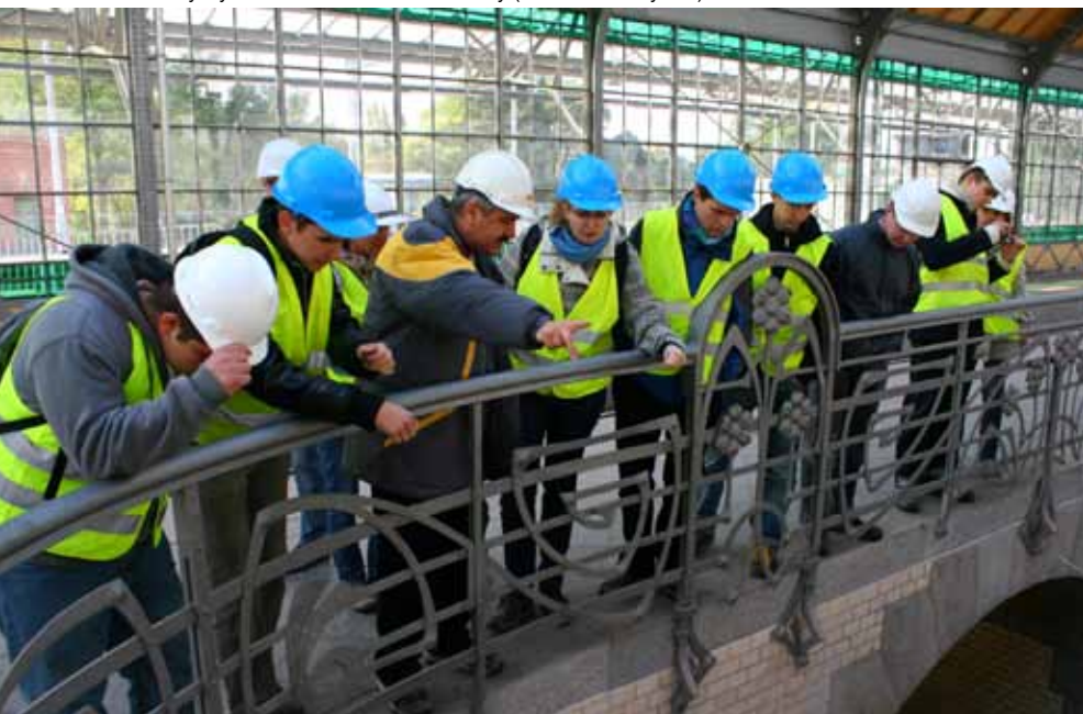
Uczestnicy wycieczki z kierownikiem budowy (fot. Marek Łużyński)
