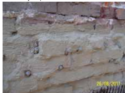
Wykonywanie przepony poziomej ścian budynku (widoczne otwory iniekcyjne wraz z umieszczonymi w nich pakierami, fot. Piotr Organek) Wykonywanie palisady metodą CFA (fot. Piotr Organek)
