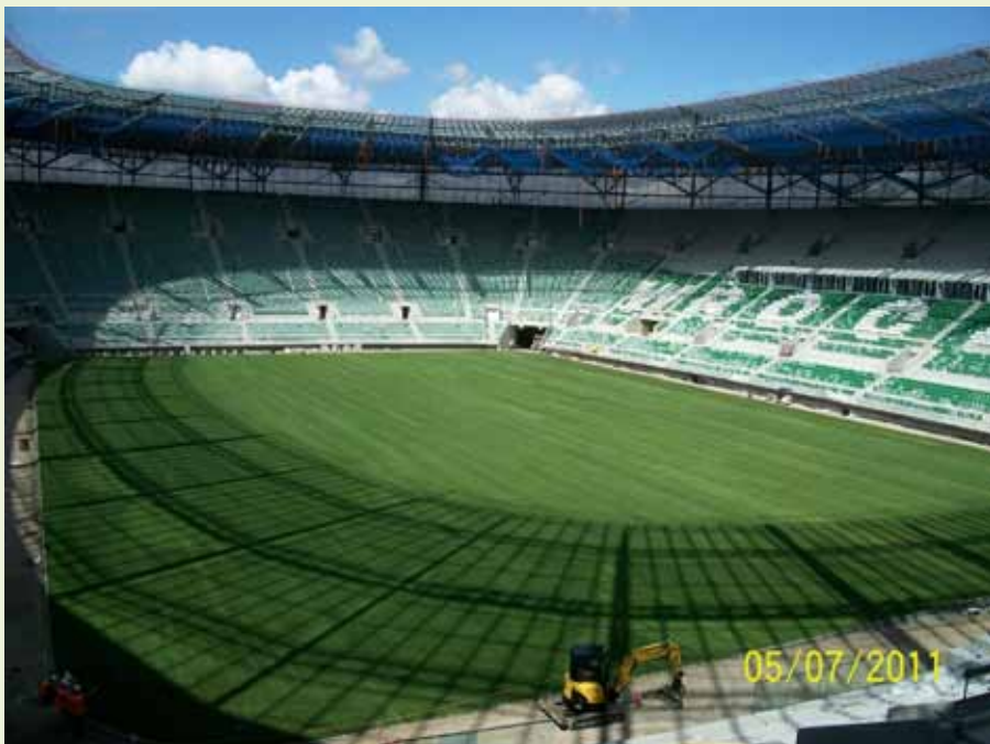
Fot. 2. Gotowa murawa boiska
