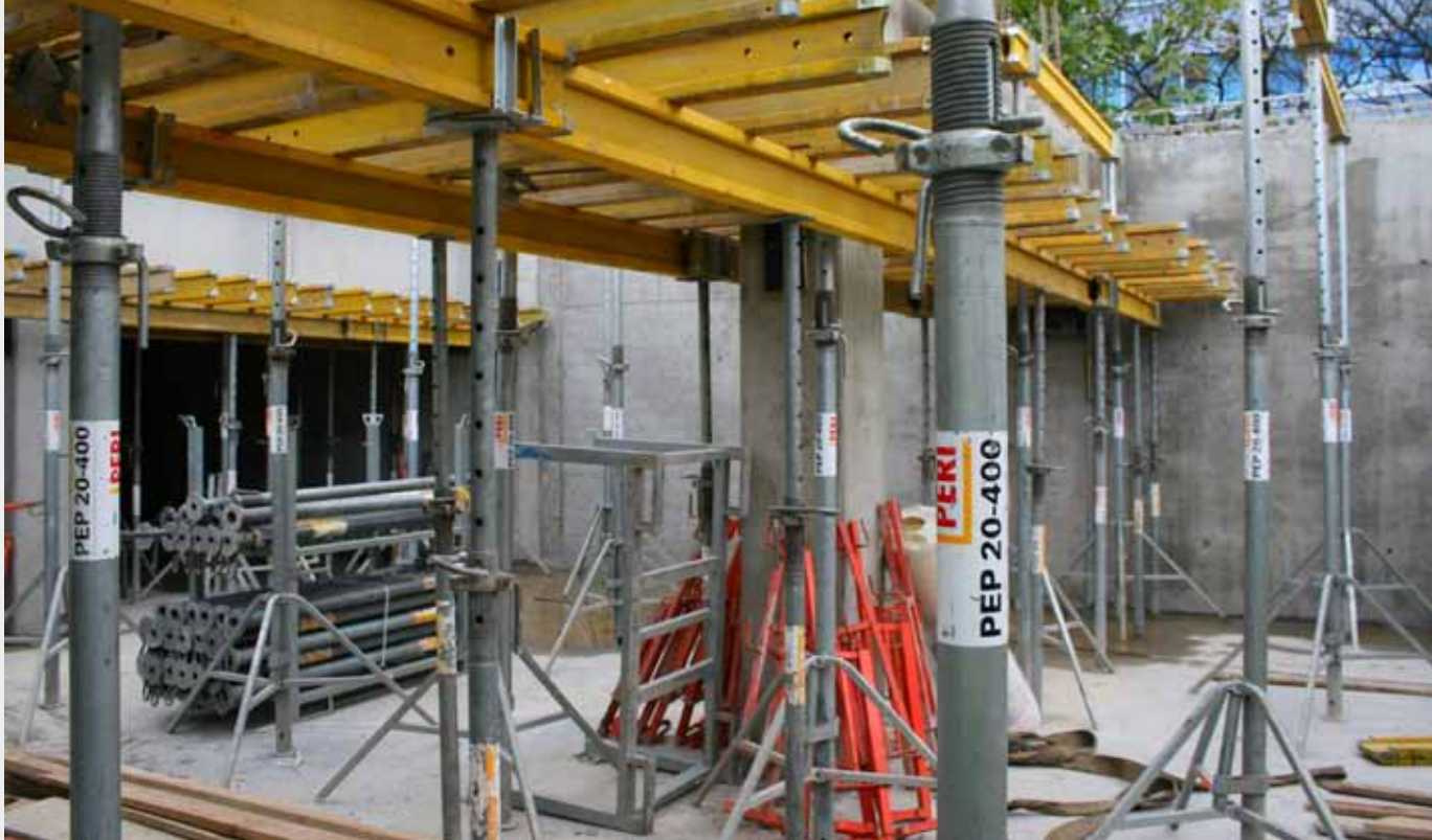
Sposób deskowania stropu w systemie Peri (fot. Marek Łużyński)
