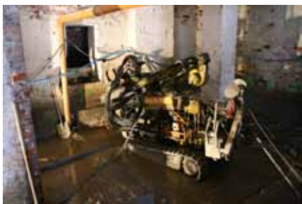
Wzmacnianie fundamentów istniejących w pomieszczeniach piwnicznych metodą jet-grouting (fot. Marek Łużyński)vvv
