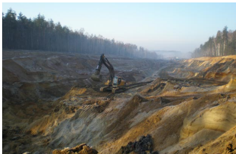
Roboty ziemne w ciągu A-4
