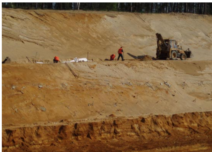
Gwoździowanie skarp przekopu w ciągu A-4
