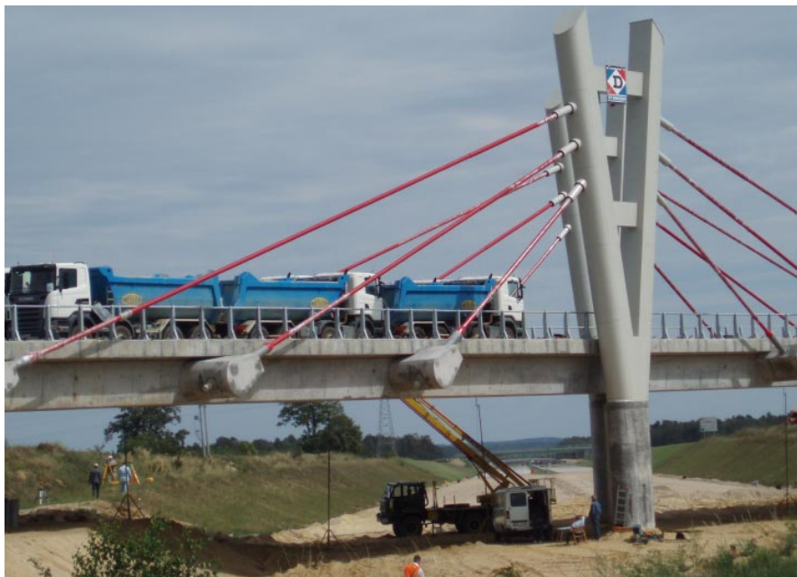
Próbne obciążenie mostu w ciągu A-4
