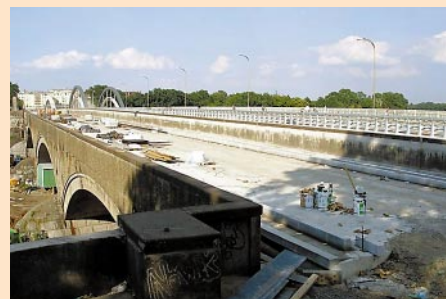
Stary most Warszawski podczas prac remontowych
