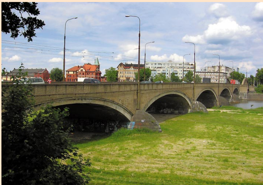
Pięcioprzęsłowy most środkowy. Jednoprzęsłowy wschodni (na drugim planie)
