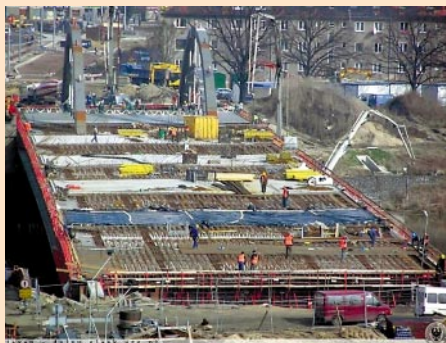
Wybetonowana prawie połowa powierzchni mostu. Trzy pompy podają beton na płytę
