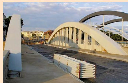
Po przeprowadzonym remoncie łuki starego mostu Warszawskiego odzyskały dawny blask
