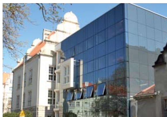
REMONT I PRZEBUDOWA BUDYNKU A10 POLITECHNIKI WROCŁAWSKIEJ, UL. NORWIDA
