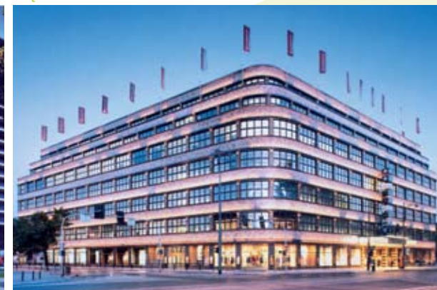
REMONT, PRZEBUDOWA I ROZBUDOWA BUDYNKU DT „CENTRUM RENOMA” WROCŁAW, UL. ŚWIDNICKA
